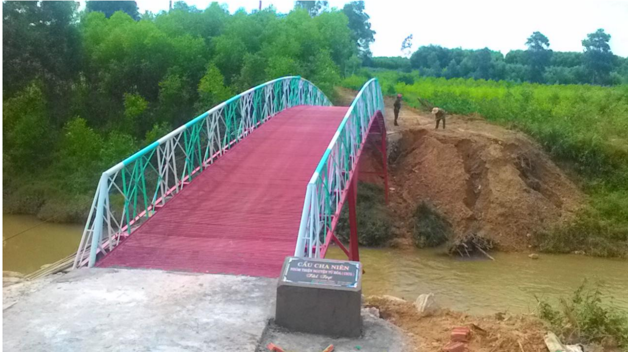
Hình 10: Cầu Cha Niên dạng vòm khá dốc, giúp tiêu tán lực ra bên ngoài khá tốt – Nguồn TỪ HÒA-CICG, 2017
