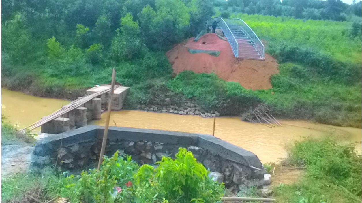
Hình 3: Mố Cầu được xây bằng đá hộc cho Cầu Cha Niên, Triệu Ái, Quảng Trị- Nguồn TỪ HÒA-CICG, 2017
