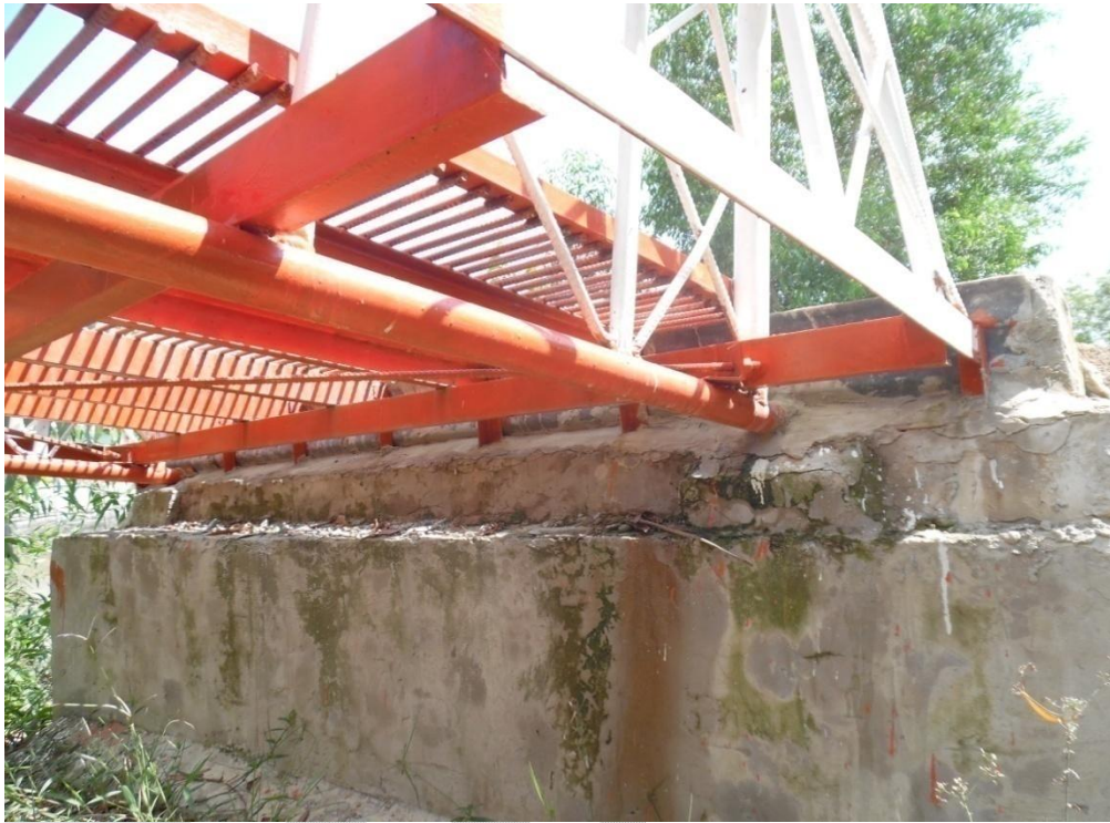
Hình 2: Mố cầu vững chắc (Nguồn: Từ Hòa-CICG, 2017)
