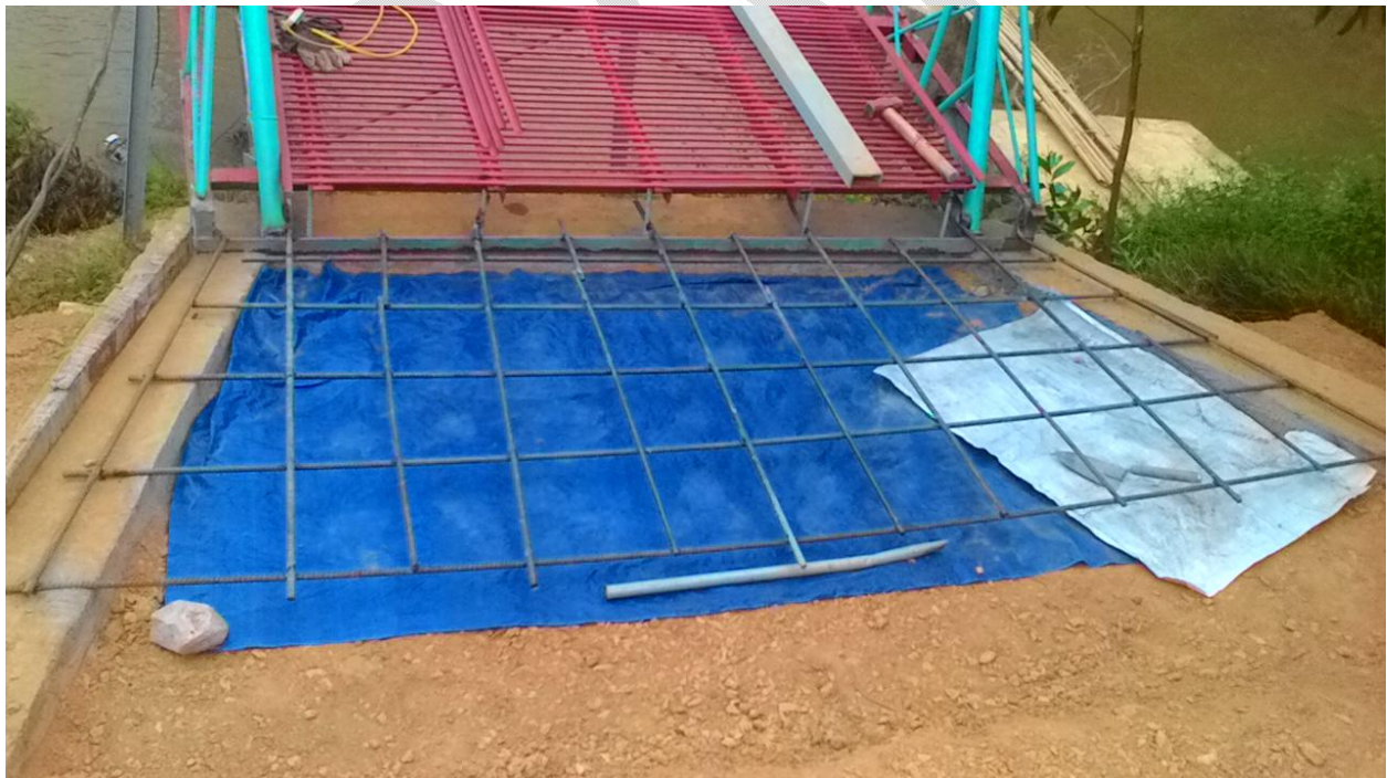
Hình 4: Cầu Cha Niên được xây dựng tiếp nối đến hai mố cầu đã được đổ dầm bê tông cốt thép
