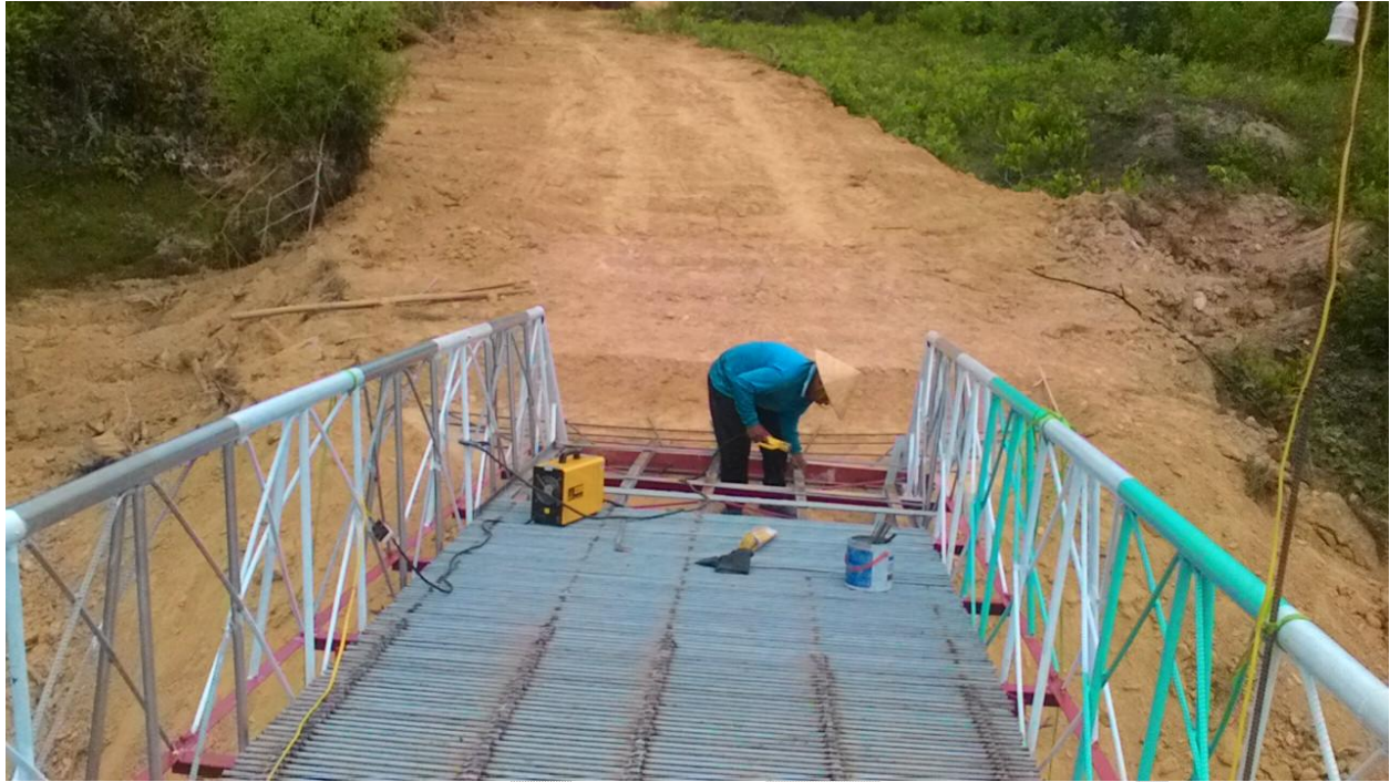
Hình 9: Mặt cầu Cha Niên và các thành tố theo phương đứng và ngang của dàn treo
